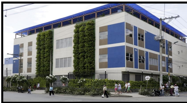
Ilustración 60 Hospital Carlos Holmes Trujillo Red de Salud Oriente ESE
